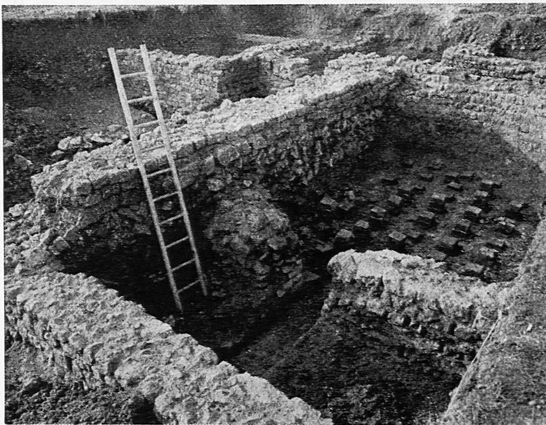
Teil des Schwitzbades. Der Fussboden ruhte auf kleinen Backsteinsäulen; in den darunterliegenden Hohlraum strömte die Warmluft ein.
