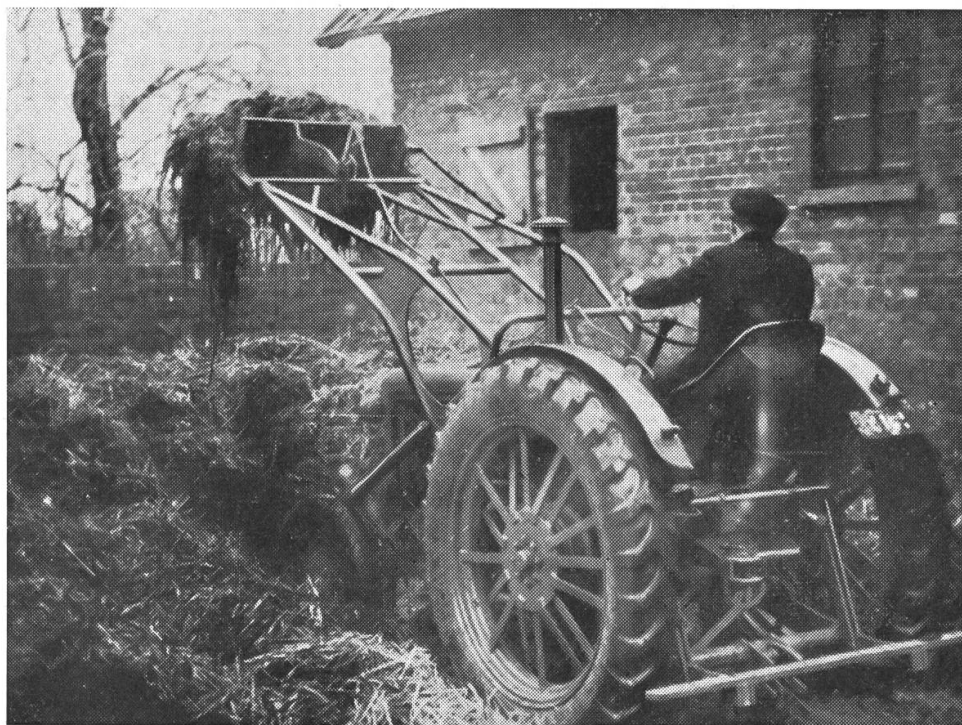
Abb. 8: Der deutsche Wittenburg-Lader am Hanomag-Schlepper R 25.
