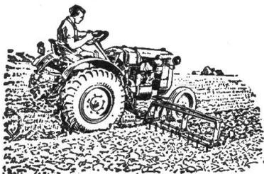
**Pflügen und Eggen** in einem Arbeitsgang jetzt auch dem kleineren und mittleren Betriebe möglich, durch die preisgünstige, fast augenblicklich an- und abmontierbare, rotierende
