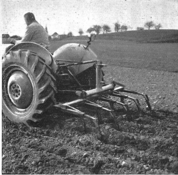
Das Vielfachgerät «Kombi» im Einsatz als Kultivator.
