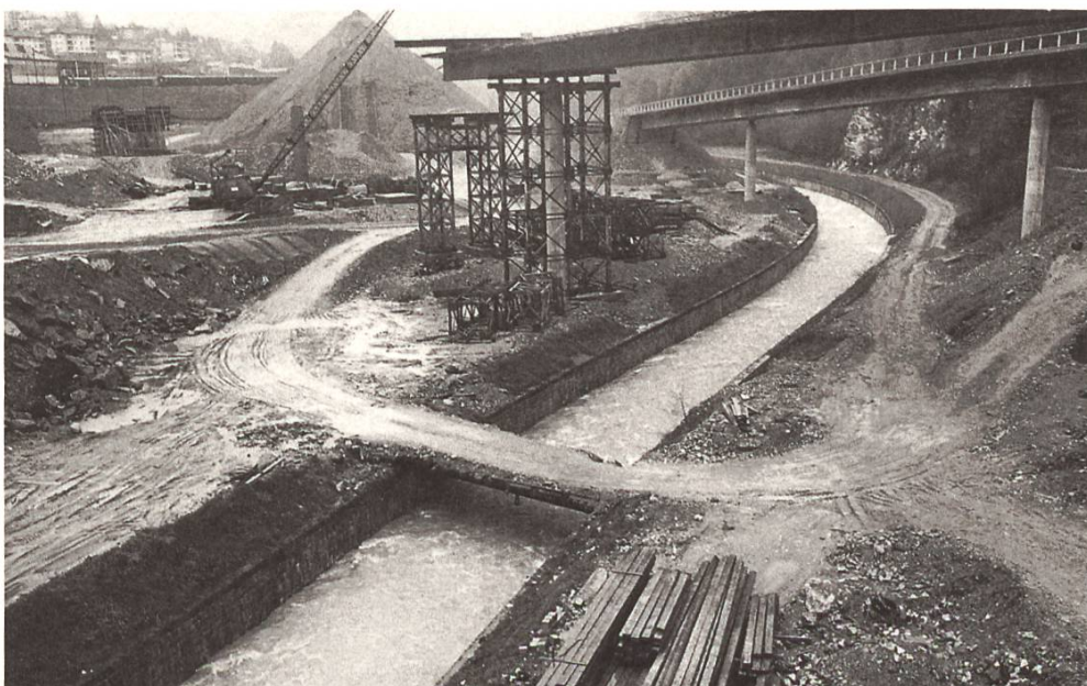
Flusskanalisierung anfangs der 60er Jahre in Airolo TI
