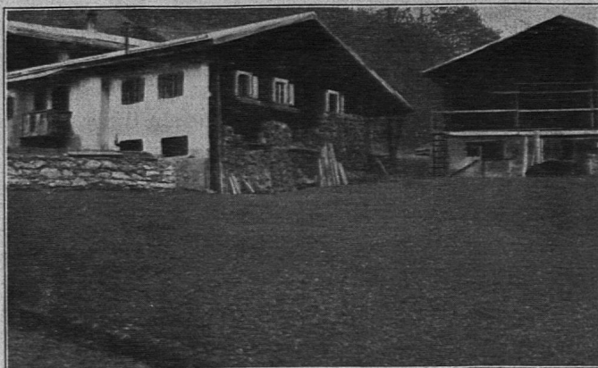
Nach beendigter Arbeit
