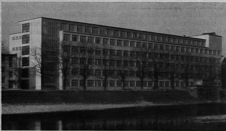
Abb. 1. Gesamtansicht von der Limmatseite.
