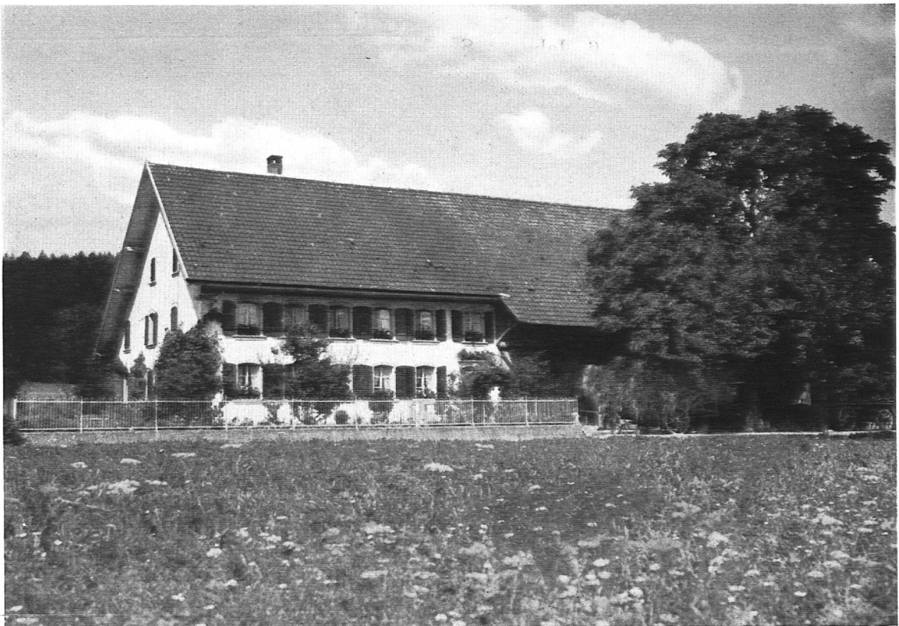
Nordostschweizerisches Dreisässenhaus in Hausen (Aargau)
