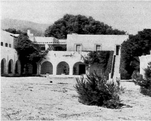
Ein Teil der Anlage des Centre national de formation de la jeunesse et des sports Bir-el-Bey, 20 km von Tunis entfernt. Das grosse Gebäude enthält die Büros und Magazine, den Vortragssaal, die Wohnung des Direktors und verschiedene Schlafräume.
