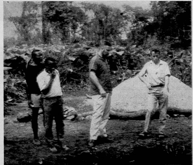
Zwei Helvetas-Bauingenieure in Westkamerun zusammen mit ihren einheimischen Mitarbeitern bei einer Bauinspektion eines Wasserversorgungsprojektes
