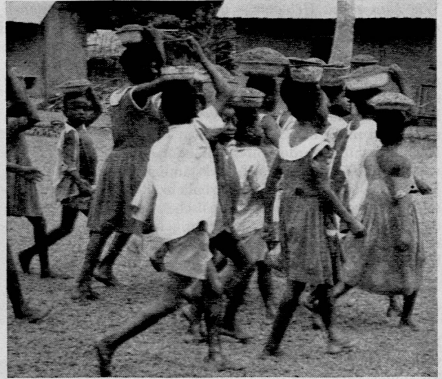
Bau einer Wasserversorgung in Westkamerun. Die Schulkinder schleppen Sand und Steine zu den Baustellen
