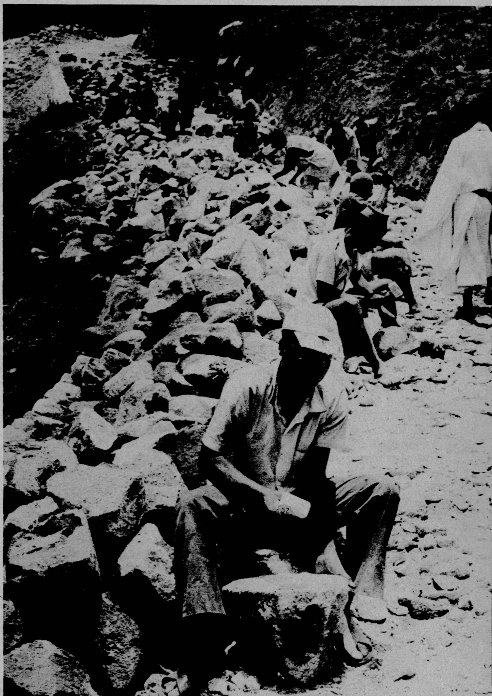
Helvetas fördert Strassenbau (Kamerun)
