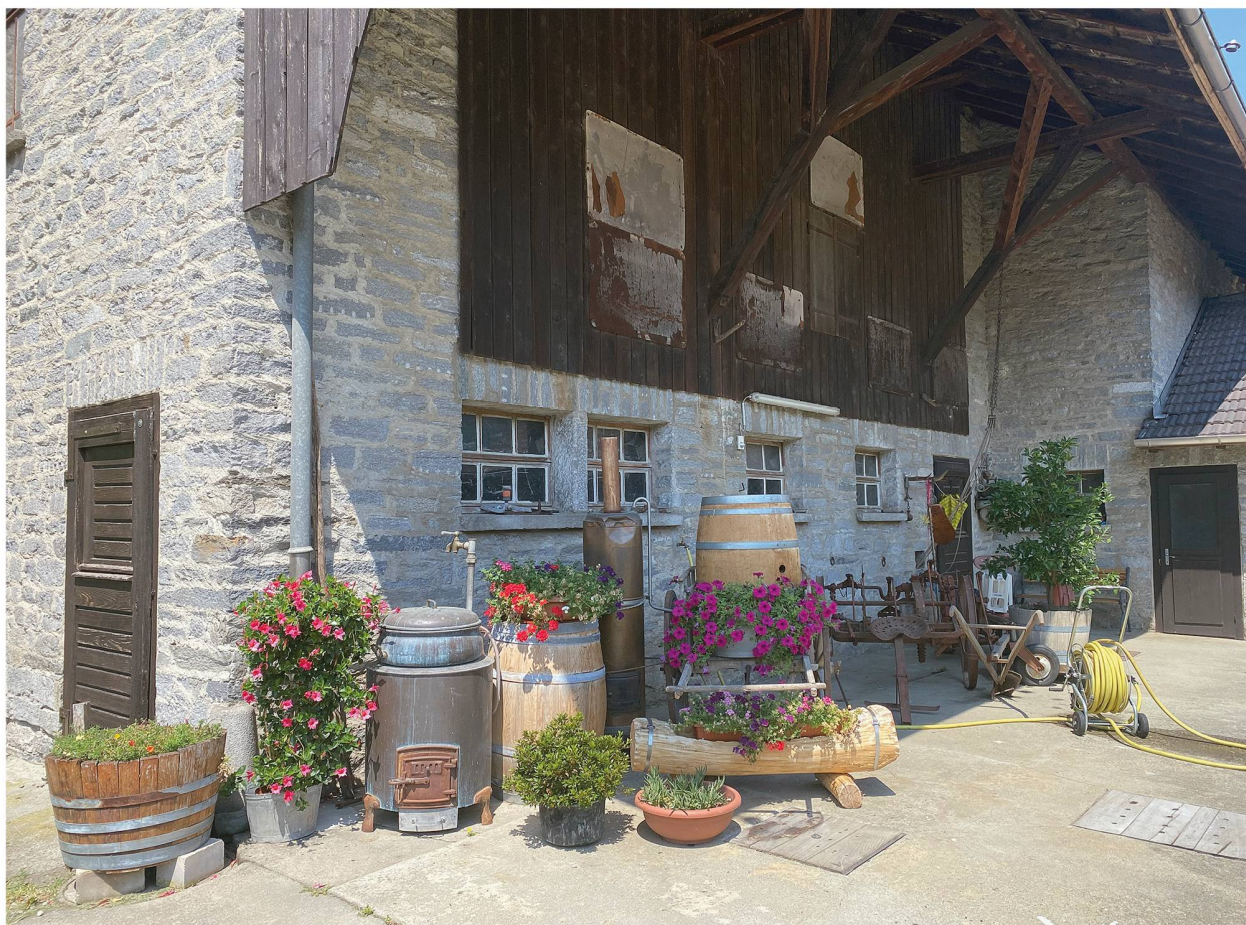
Figura 6: Vecchia stalla in disuso potenzialmente ancora utilizzabile dalle rondini ma non più accessibile in quanto finestre e porte sono chiuse.
