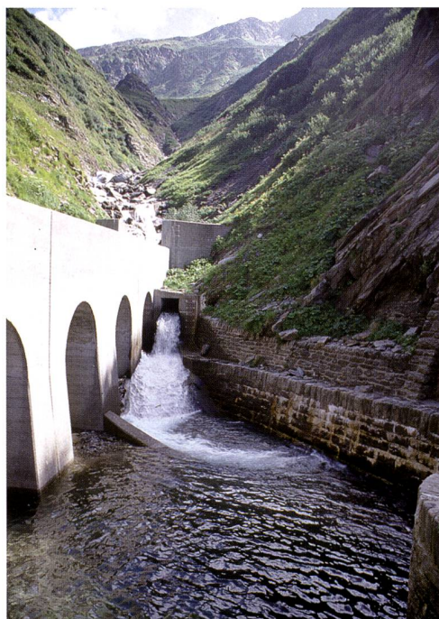
Fig. 4 – Prese di captazione delle acque della Garegna a Froda in Val Canaria (foto F. Rampazzi).
