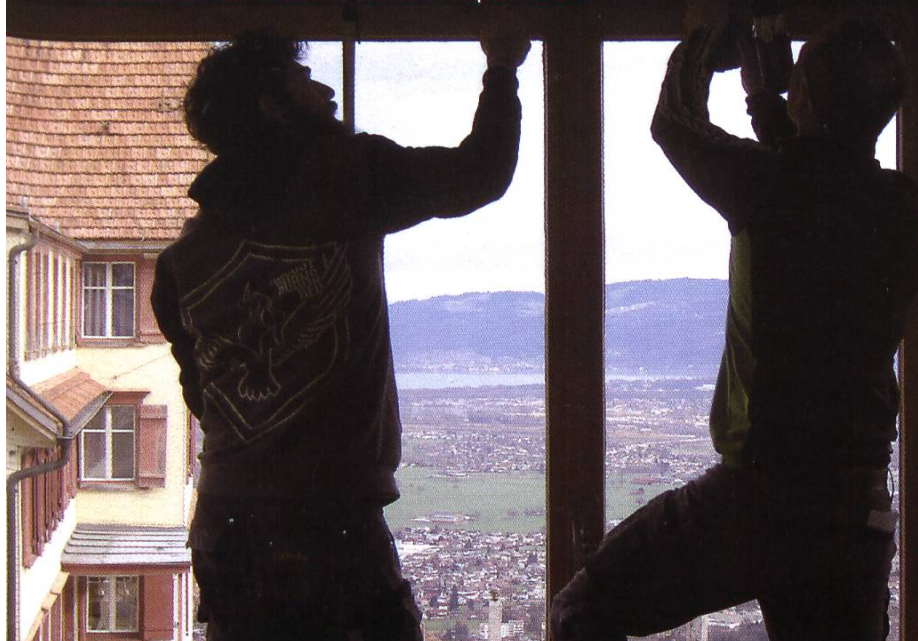
Einbau einer Akustikdecke im Speisesaal.
