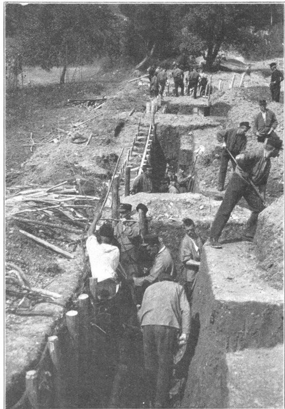
Erstellen eines Schützengrabens. 1916.
