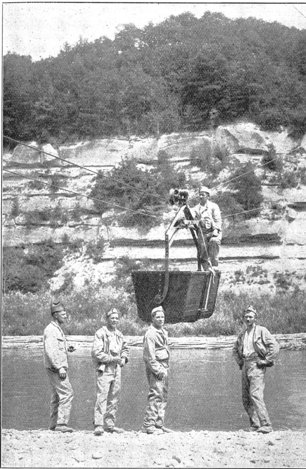
Seilbahnbau des Sap. Bat. 3 W. K. 1929. — Transportwagen auf der Strecke.
