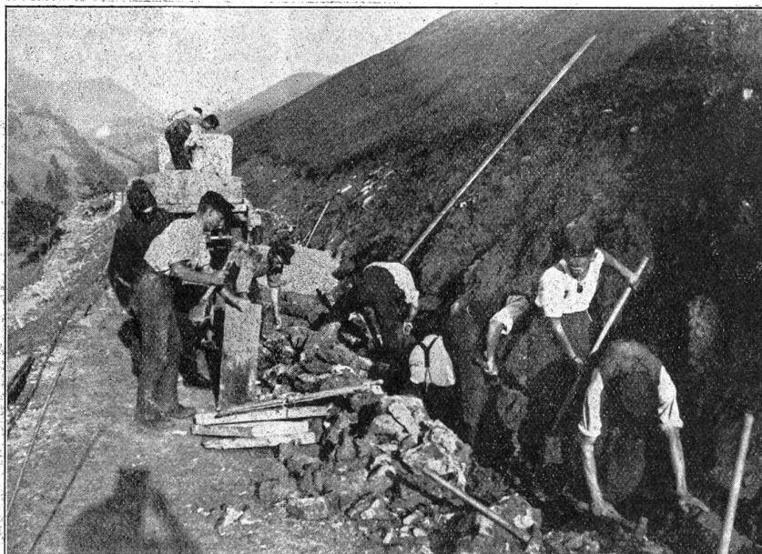
Bau der Scheltenstrasse 1915 durch die Sappeure.
