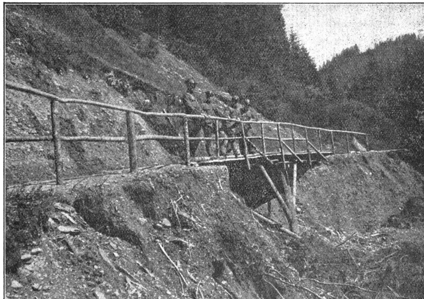
Stege- und Wegebau durch Sappeure im Hochwasserdienst 1927 im Emmental.
