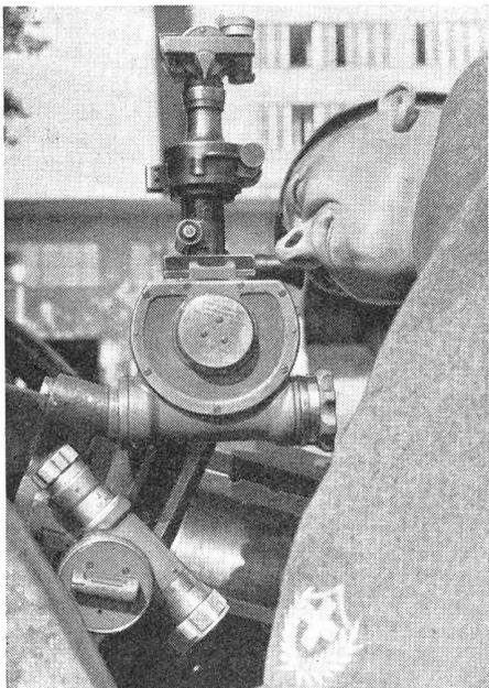
**Artilleriearbeiten.** Richtübungen am 7,5-cm-Feldgeschütz. Das Nachrichten mit dem Panorama-Aufsatz bei eingespielter Maximalelevation des Geschützrohres ist mit einigen Schwierigkeiten verbunden.
