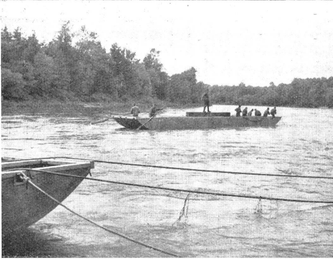
Verankern eines Ponton-Vierteilers aus Leichtmetall und Einfahren in die Brückenlinie.
