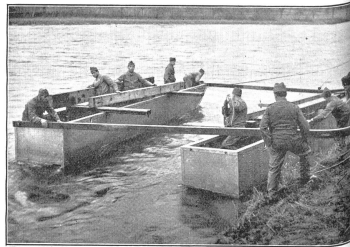
Auf die Länge der Stützbalken wird der linke Ponton abgestoßen, indes in der Mitte bereits mit dem Aufbau der Ladebrücke begonnen wird. (A Er 0307.)
