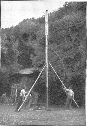
Leitungsbau. Befehl: Von Fr . . . nach Im . . . ist eine doppelte permanente Freileitung zu erstellen. Nach genauer Erkundung der Linienführung beginnt sofort das Aufstellen der Leitungsstangen. (A Er 0301.)
