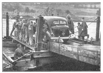
Die Drahtseilgeländer sind noch nicht gestreckt, als der erste Wagen zum Uebersetzen auf die Fähre dirigiert wird. Knapp 45 Minuten dauerte der Einbau der Fähre. (A Er 0305.)
