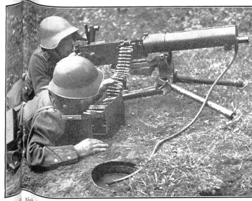
Beim Schießen des Mg. ist es empfehlenswert, ein zweites Gefäß mit Wasser in der Nähe der Mg-Stellung, so wird das freie Ende des Dampfeschlauchs zweckmäßigerweise dort hineingelegt. In vorbereiteten Vertiefungen empfindet es sich, zum gleichen Zweck Wasserbehälter (alte Eimer) neben den Mg. einzuzugraben. (A Er 449.) Dans le tir, il y a de l'eau à proximité de la position de la mitr., il est intéressant de placer le tuyau d'échappement dans le même but, des récipients (vieilles cuvettes ou casseroles) à proximité de la mitr. Quando si tira, l'estremità libera del tubo. Nelle posizioni preparate in precedenza, si consiglia l'istituto di interrare a tale scopo dei recipienti d'acqua (vecchi secchi o simili).
