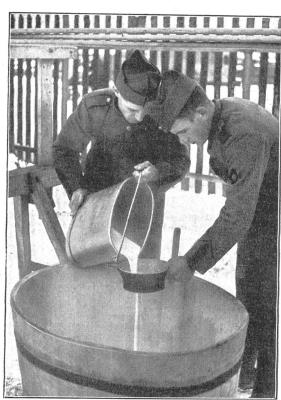
In salzarem Holzuber sind ferner pro Zelt 2 Liter lauwarmes Wasser bereitzustellen und die aufgelöste Imprägniermasse durch ein feinmaschiges Sieb einzufüllen. (A Ev 0520.)
