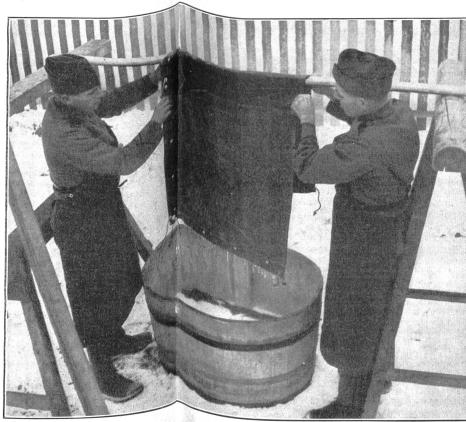
Links: Nach zwei Stunden sind die Zelte aus der Flotte zu ziehen und gut in den Zuber abtropfen zu lassen, damit die abtropfende Flüssigkeit, nach entsprechendem Nachfüllen, für die nächste Serie wieder verwendet werden kann. Wichtig ist, daß die imprägnierten Zelte rasch, wenn möglich in Tentschuppen bis zu einer Temperatur von 100 ° C getrocknet werden. (A Ev 0516.)
