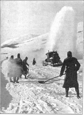
Oeffnen einer Alpenstraße nach starkem Schneefall durch Straßenunterhalt_DETACHEMENT. (A Er 525.) Ouverture d'une route alpestre, après une forte chute de neige, par un détachement d'entretien des routes. Dopo un'abbondante nevicata, il distaccamento per la manutenzione stradale apre alla circolazione una strada alpina.
