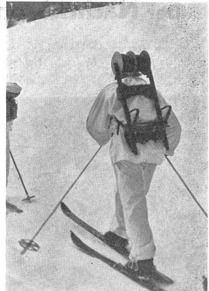
**Telephon-Soldat** beim Bau einer doppeldrähtigen Telephonverbindung. — **Soldat du téléphone** construisant une liaison téléphonique à double-fil. — **Soldato telefonista** che tende i fili per un collegamento telefonico doppio. (Zens.-Nr. VI Br. 9244.)
