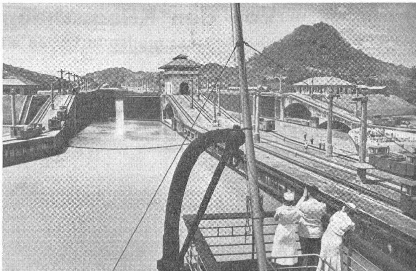
Dampfer bei der Einfahrt in die Miraflores-Schleuse auf der Pacific-Seite des Panamakanals. — Vapeur à l'entrée de l'écluse de Miraflores sur le côté Pacifique du canal de Panama. — Vapore all'entrata nella chiusa di Miraflores dal lato verso il Pacifico del Canale di Panama.
