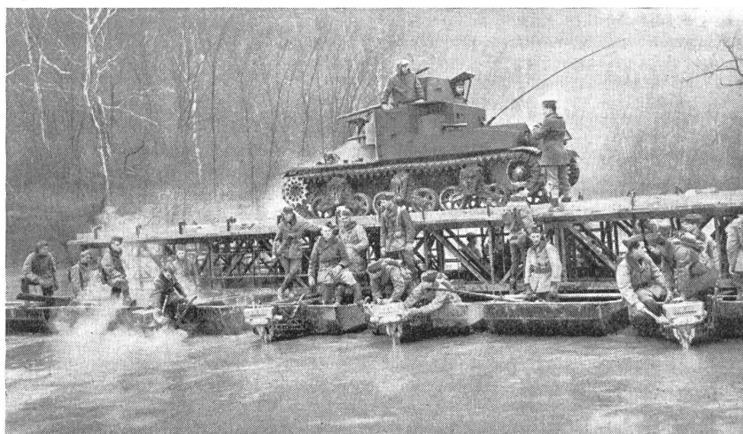
Uebersetzen eines mittleren USA-Panzerwagens über einen Wasserlauf mittels Pontonfähre der zuge teilten Panzer-Pioniere. — Char moyen américain traversant un cours d'eau au moyen d'un bac de pontons monté par les pionniers attribués aux unités blindées. — Passaggio di un corso d'acqua di un carro armato medio degli Stati Uniti mediante un traghetto costruito dai pionieri attribuiti alle truppe corazzate.
