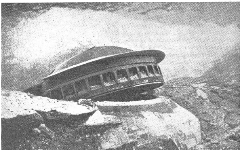
Die Wirkung der «Dickten Berta»: Durch den Gasdruck der über 100-kg-Sprengladung einer 42-cm-Granate aus ihrem Drehkranz herausgehobene Panzerkuppel eines Forts des Antwerpener Festungsgürtels. — L'efficacité de la «Grosse Bertha»: la coupole tournante d'une tourelle blindée d'un fort de la ceinture fortifiée d'Anvers arrachée par la déflagration de la charge explosive de plus de 100 kg. d'un obus de 42 cm. — L'effetto della «Dicke Berta»: con la pressione d'aria di oltre 100 kg. di esplosivo di una granata da 42 cm., viene strappata dalla sua corona la cupola corazzata di un forte della cintura fortificata di Antwerpen.
