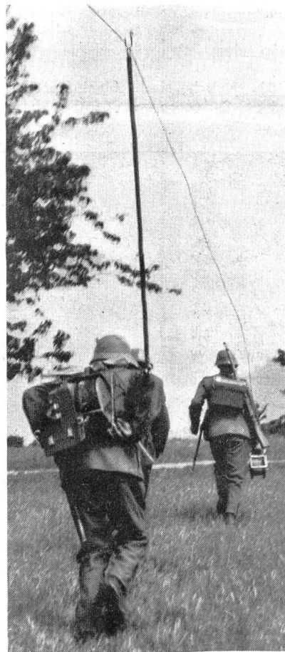
Inf.-Tel.-Patr. beim Linienbau. — Construction de lignes par une patrouille Tf. d'infanterie. — Patt. ff. di fant. alla costruzione di una linea. (Zens.-Nr. VI H 10430.)
