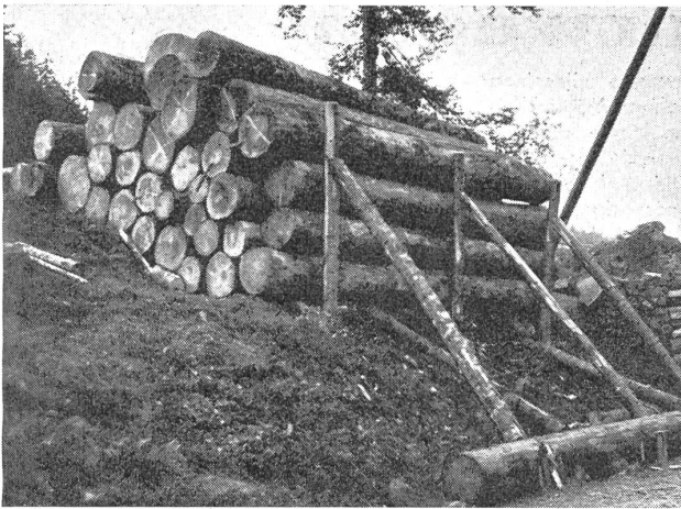
Vorbereitetes improvisiertes Tankhindernis, durch Sprengung der Verstrebungen werden die Baumstämme die Straße versperrt. — Obstacle anti-tank improvisé: un barrage de troncs d'arbres est provoqué par explosion. — Ostacolo anticarro improvvisato preparato; i tronchi d'albero sbarreranno la strada. (Z.-Nr. N/V/10039.)
