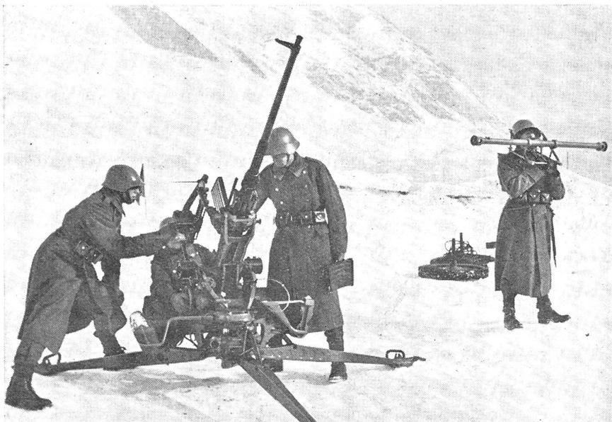
**Gefechtsbereites 20-mm-Flabgeschütz.** Auf die Distanzmeldung des Meßmannes (rechts) stellt K 2 die Visiervorrichtung entsprechend ein, K 1 (sitzend) visiert das Ziel an und feuert, während K 3 (rechts neben dem Geschütz) die Munitionszufuhr besorgt. (Zensur-Nr. VI B 1036.)
