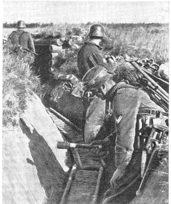
... der Bereitstellung: In den ruhigeren Sektoren Nordrußlands sind Kampf- und Verbindungsgraben sorgfältig mit Unterständen und Holzrostern versehen worden.
