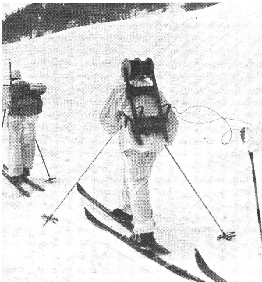
Bautrupps beim Vorbau einer doppeldräftigen Stammlinie. (Z.-Nr. VI Br 9244.)
