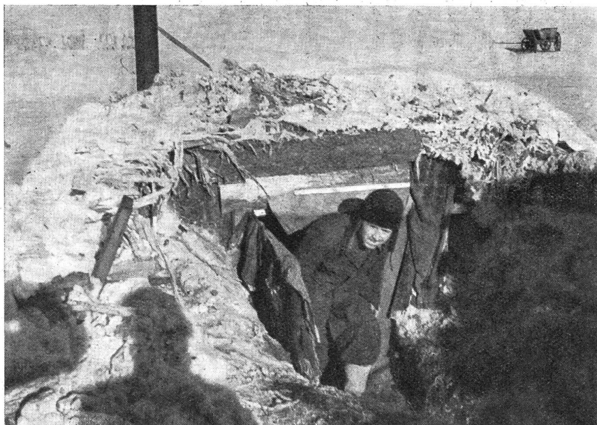
Italienischer Unterstand in der Ebene des Donezbeckens.
