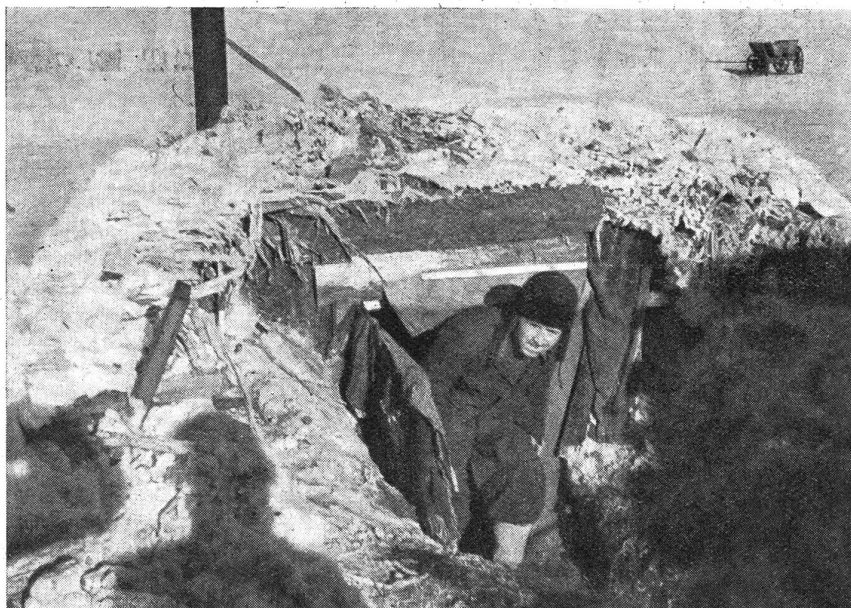
Italienischer Unterstand in der Ebene des Donezbeckens.
