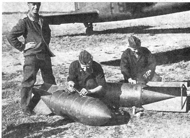
Deutsche Bombenwarte beim Einsetzen der Seitenzünder in Sprengbomben mittleren Kalibers.
