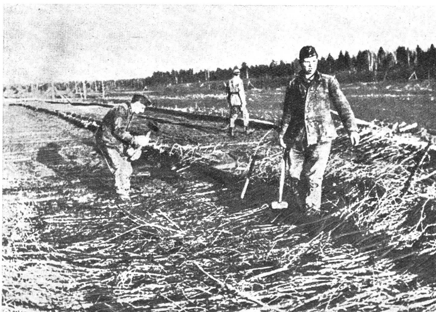
Nur der Knüppeldamm, der Meter um Meter aus gefällten Bäumen und Aesten erstellt werden muß, vermag den Nachschub an die Kampffront zu sichern.
