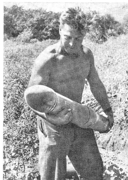
Raketen-Granate des deutschen Nebelwerfers; der untere Teil (rechts des hinteren Führungsringes) dürfte den Raketenatz enthalten.
