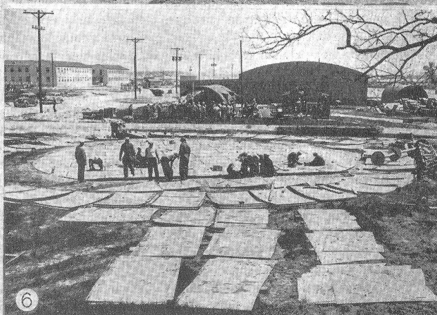
⑤ An der Drehbank in der Maschinenwerkstatt. Solche Werkstätten wurden ebenfalls in allen alliierten Invasionsräumen sofort eingerichtet. ⑥ Hier sehen wir die Reparatursoldaten bei der Errichtung eines großen Wasserbehälters, denn Wasser ist äußerst wichtig für die Truppen.
