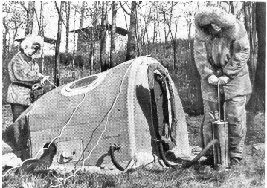
Die amerikanische Armee und ihre «Schneckenhäuschen»: In 3 Minuten ein fixfertiges Zelt. Die unermüdlich fähige Erfindungsgabe der amerikanischen Heeresleitung hat die in den «WK» einrückenden Truppen kürzlich mit einer neuen Art von «Tischlein-deck-dich» überrascht. Ein kleines Päcklein, wird es innert kürzester Zeit zum komfortablen Zelt, das für zwei Mann bequem Platz bietet und einer Schneelast von 250 kg sowie den stärksten Stürmen Trotz bietet. Mittels Handpumpen werden die Zwischenwände des ca. 1½ m hohen und 2 m langen Zeltes mit Luft gefüllt, wobei sich die zusammenlegbaren Seitenstützen aufrichten und die eingeschlossene Luftschicht außerdem isolierend wirkt.
