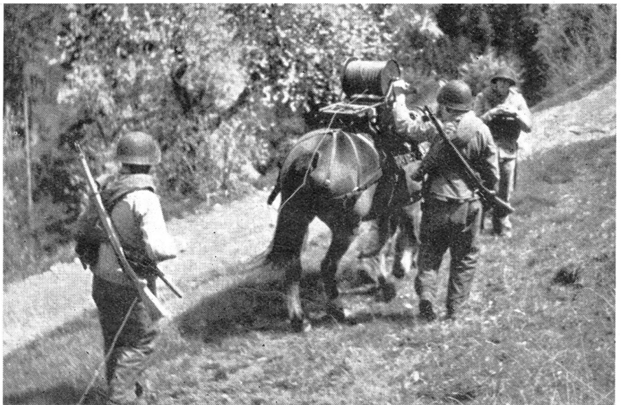
Das verlegte Kabel wird wieder eingezogen.
