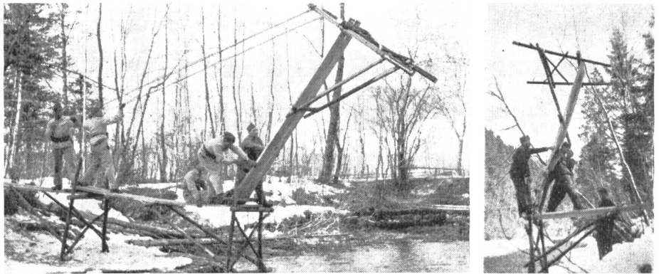
Einbau des Klappsteges dch. Gr.-Kp. 15 im WK 1953 über die Emme. Einbau des Klappsteges.
