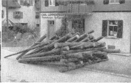
Rundholzsperrre auf einer Dorfstraße. Weil es sich im Bild nur um ein friedensmäßiges Beispiel handelt, sind die Rundhölzer nicht eingegraben und erstreckt sich die Sperrre nur über die halbe Straßenbreite.
