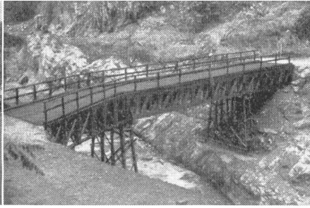
Eine von Sappeuren gebaute Brücke über ein Tobel im Gebirge.
