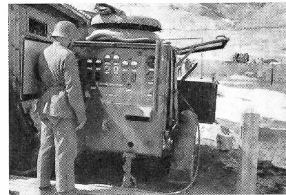
Elektrische Zentrale, welche die schwere Flab-Btr. mit Strom versorgt.
