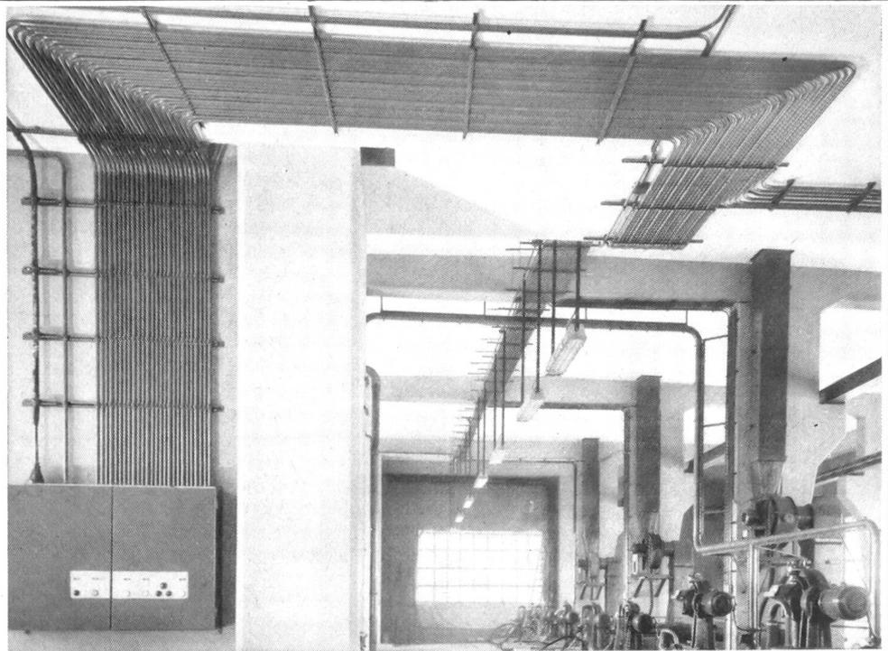
Woertz-Profilschienen No 4382/4383 aus Stahl oder Anticorodal und Zubehörteile ermöglichen rasche und übersichtliche Verlegung von Rohr- und Kabelsträngen. Die gleichen Profilschienen mit entsprechenden Verbindungs-Stücken dienen auch zum Bau von Schalttafeln und Verteilgestellen.
