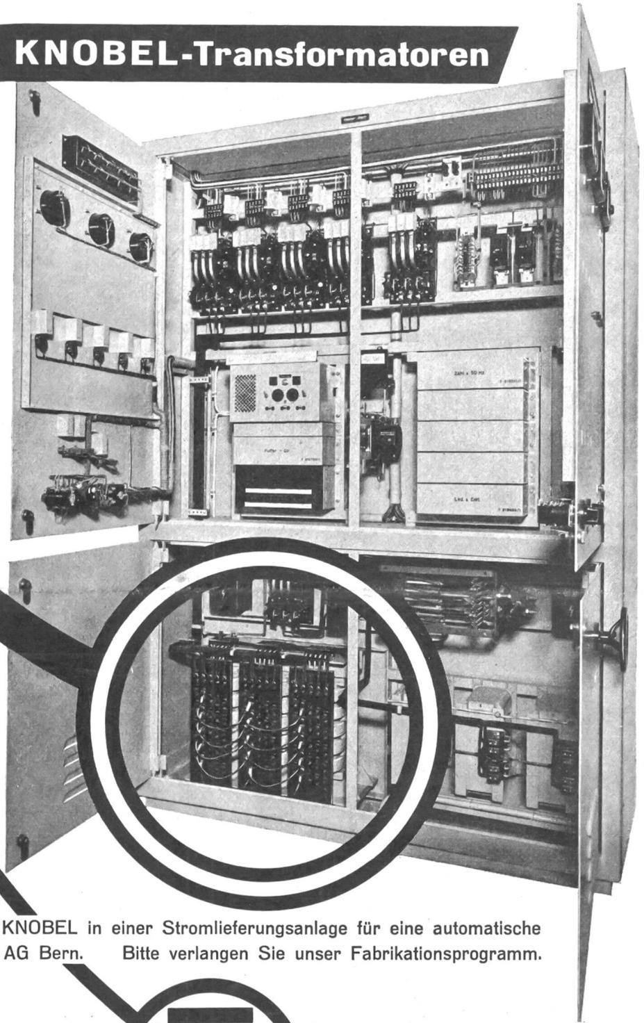
Gleichrichter-Transformatoren KNOBEL in einer Stromlieferungsanlage für eine automatische Fernmeldezentrale der Hasler AG Bern. Bitte verlangen Sie unser Fabrikationsprogramm.
