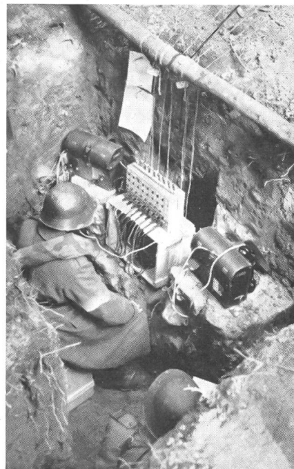
Die eingegrabene Telephonzentrale verbindet den Kdt. mit den einzelnen Frontabschnitten und Stützpunkten.
