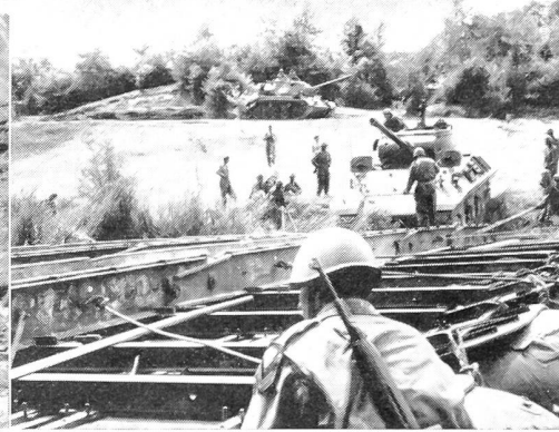
Brückenbau italienischer Pioniere mit amerikanischen Bauelementen, die, auf Gummischwimmern montiert, sogar schwere Panzer über kleine Flußhindernisse rollen lassen.
