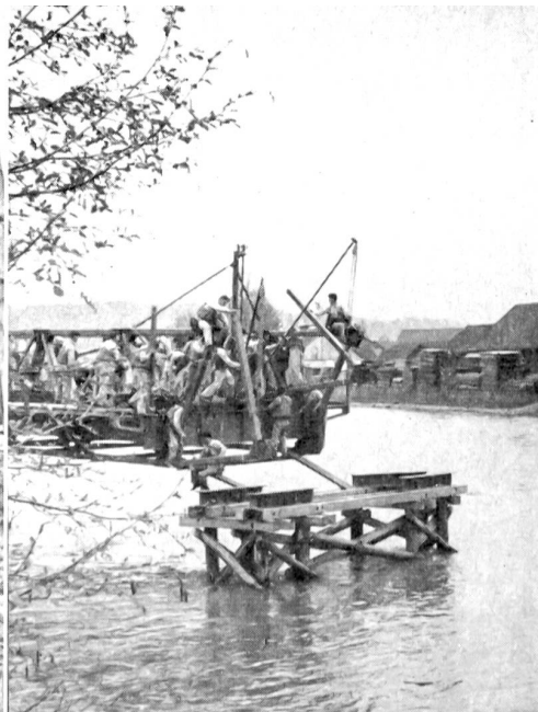
Bau einer Stahlfachwerkbrücke.
