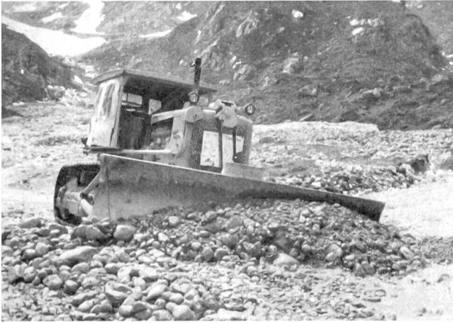
Bulldozer an der Arbeit.
