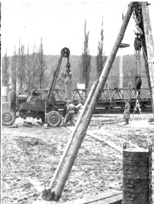
Arbeit mit dem Erdbohrgerät.
