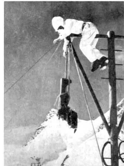
Seilbahnbau im Hochgebirge.
