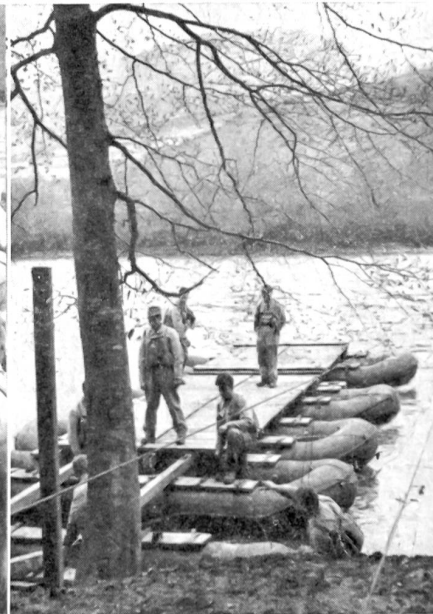
Steg Modell 42 (Schlauchbootsteg) für Fahrzeuge bis 2,5 Tonnen. Genie-RS Brugg.
