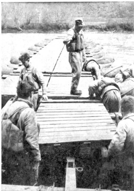
Steg Modell 42 (Schlauchbootsteg) für Fahrzeuge bis 2,5 Tonnen. Genie-RS Brugg.
