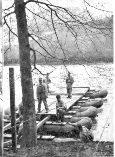
Steg Modell 42 (Schlauchbootsteg) für Fahrzeuge bis 2,5 Tonnen. Genie-RS Brugg.
